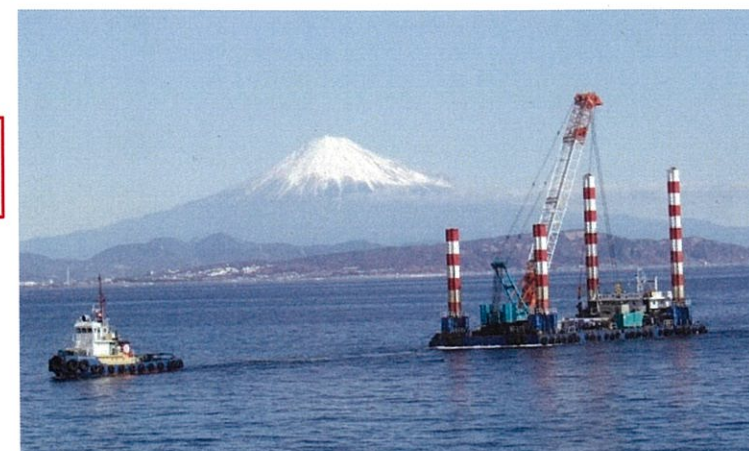
図-5 杭打船の曳航
