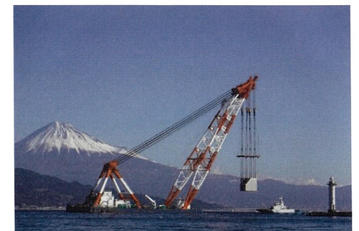
図-6 起重機船によるケーソン運搬
